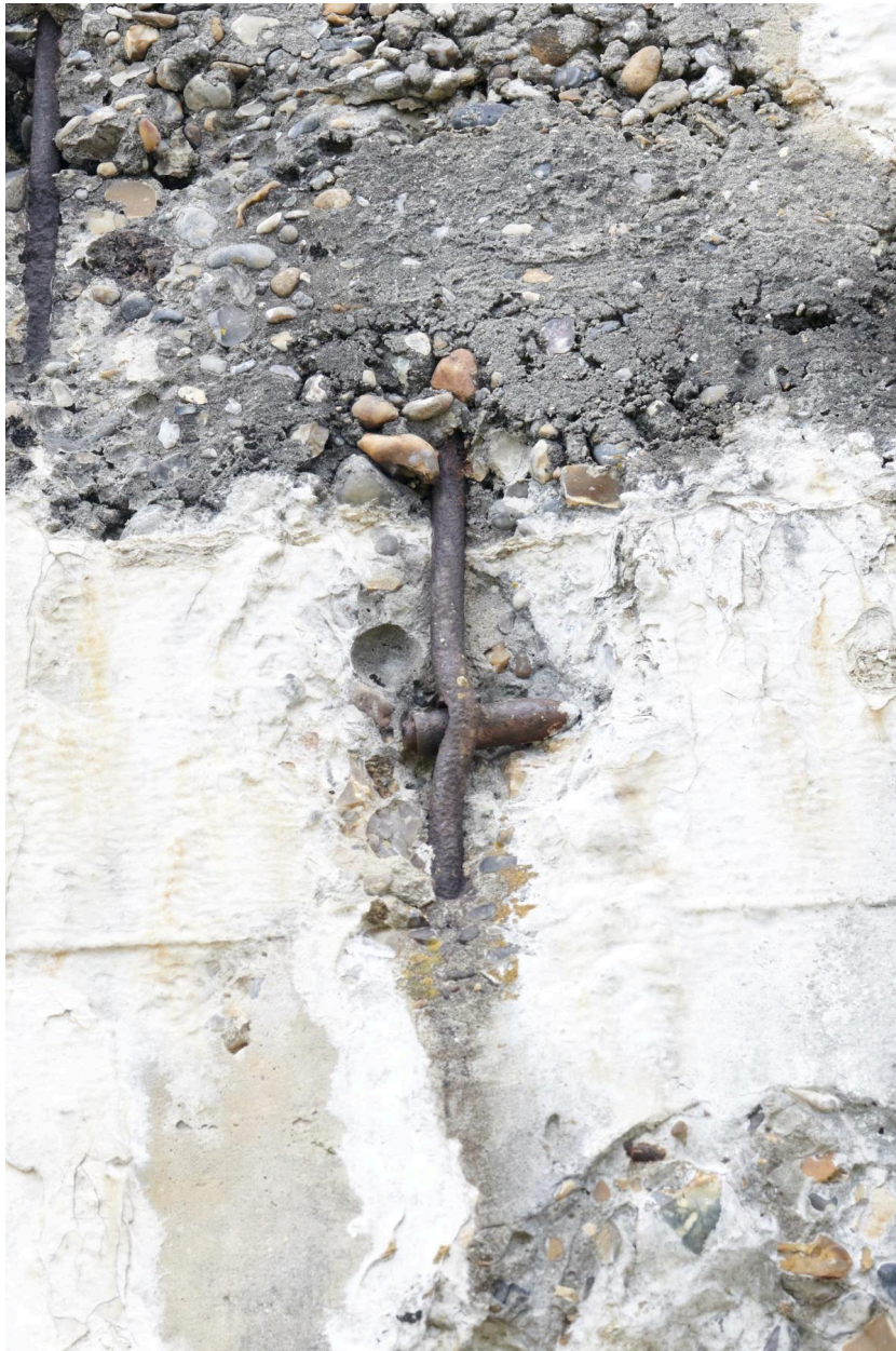
Balle allemande figée dans un fer à béton au-dessus de l'entrée de la casemate.
