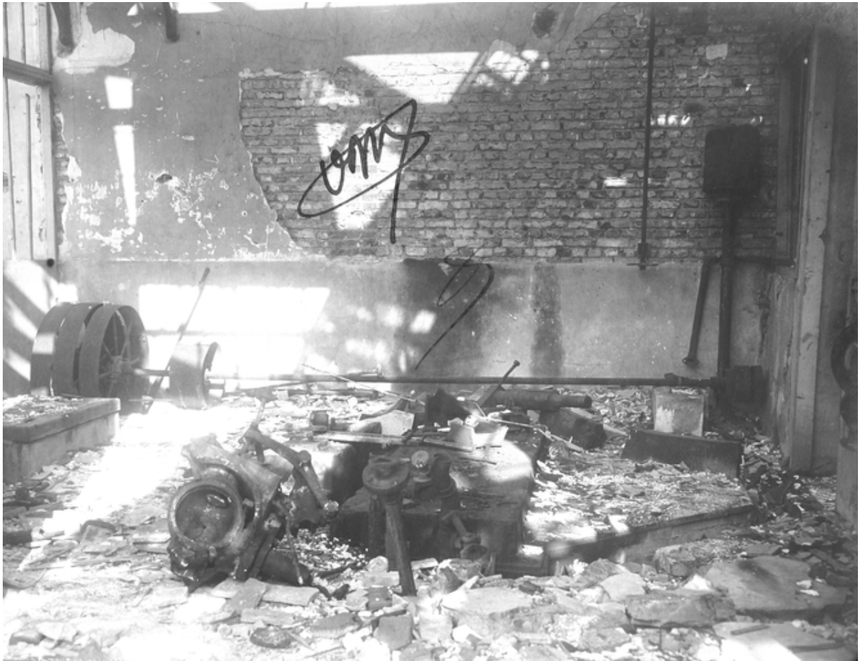
La salle des machines dévastée, vers 1919 (AD Aisne).
