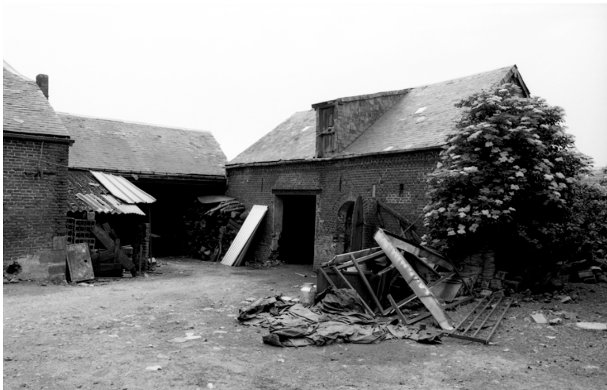
Elévation sur cour de l'étable ouest.
