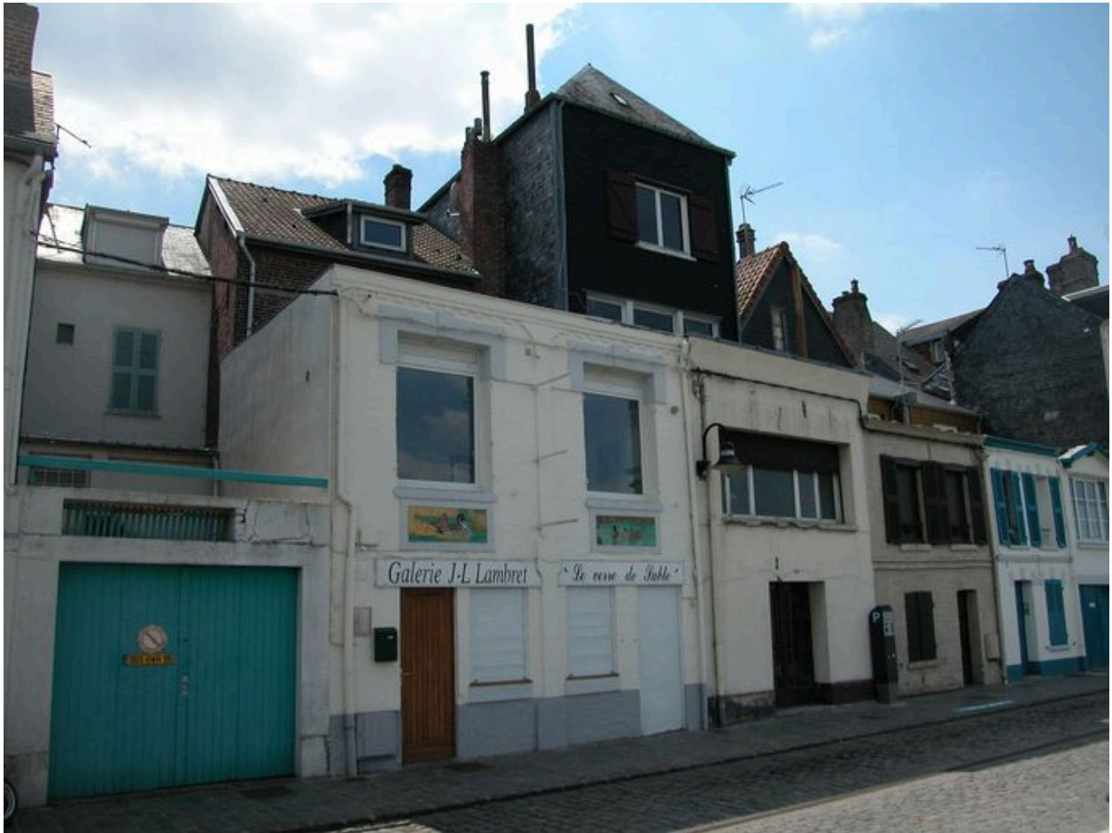
Façades postérieures des maisons de la rue de la Ferté et avancées sur le quai Blavet (AI 153, 154, 155).
