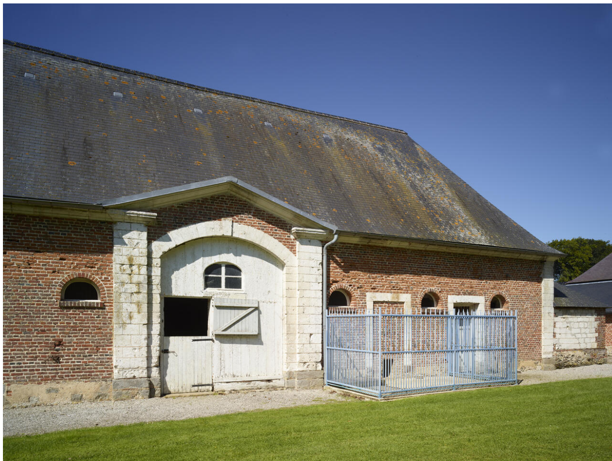
Vue de l'extrémité droite du grand bâtiment des communs avec le chenil, à l'ouest du château.
