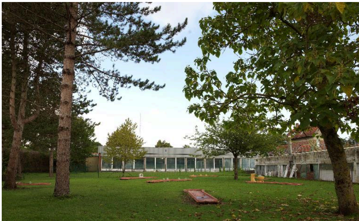
Vue de la façade arrière (sud) de la piscine Plein Soleil depuis le minigolf.
