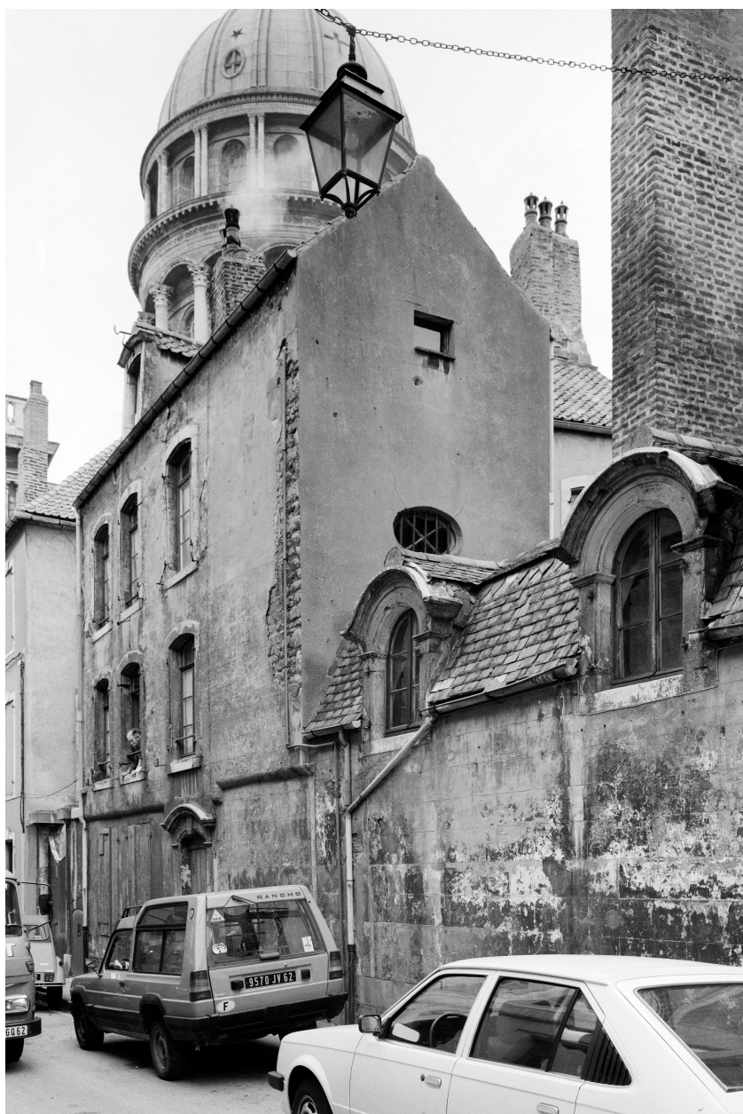
Vue d'angle sud-est avant restauration.
