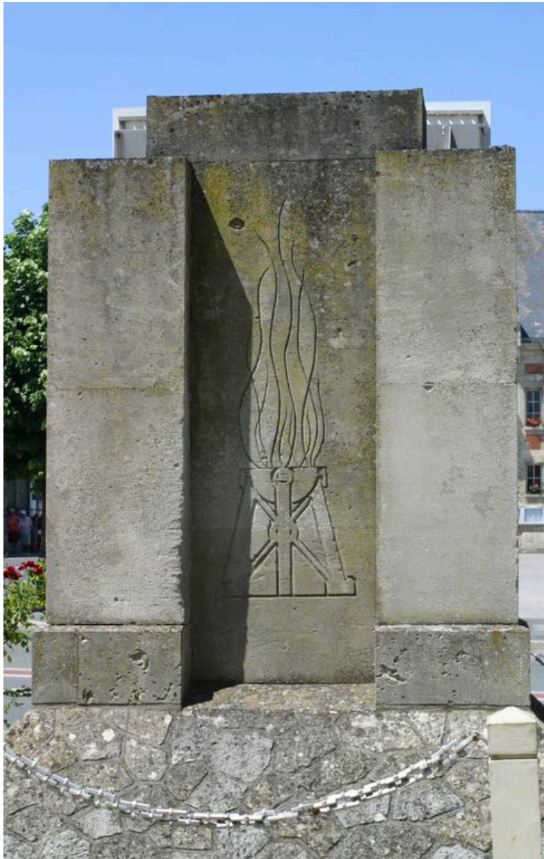
Vue postérieure du monument aux morts.
