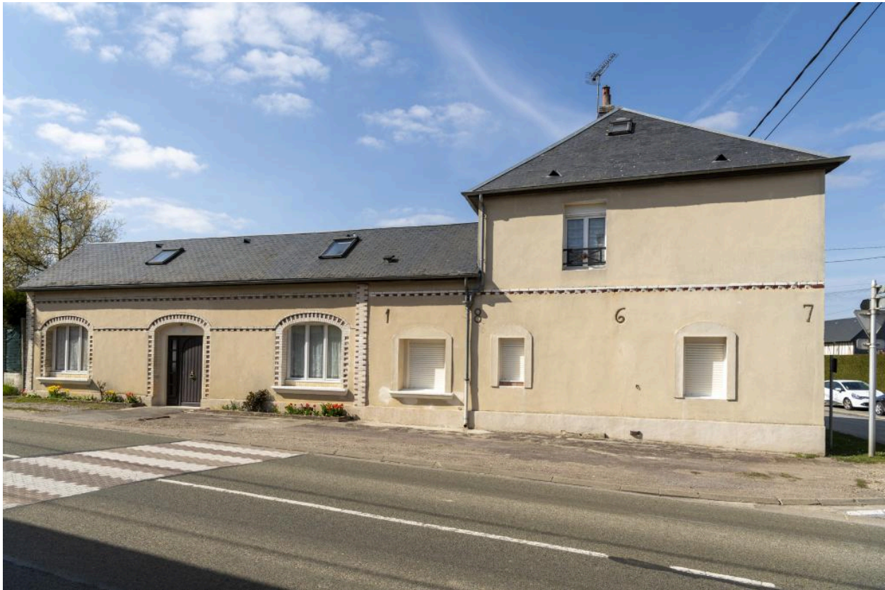
Ancien café, date portée: "1867", n°9 route de Rouen, vue depuis le sud.
