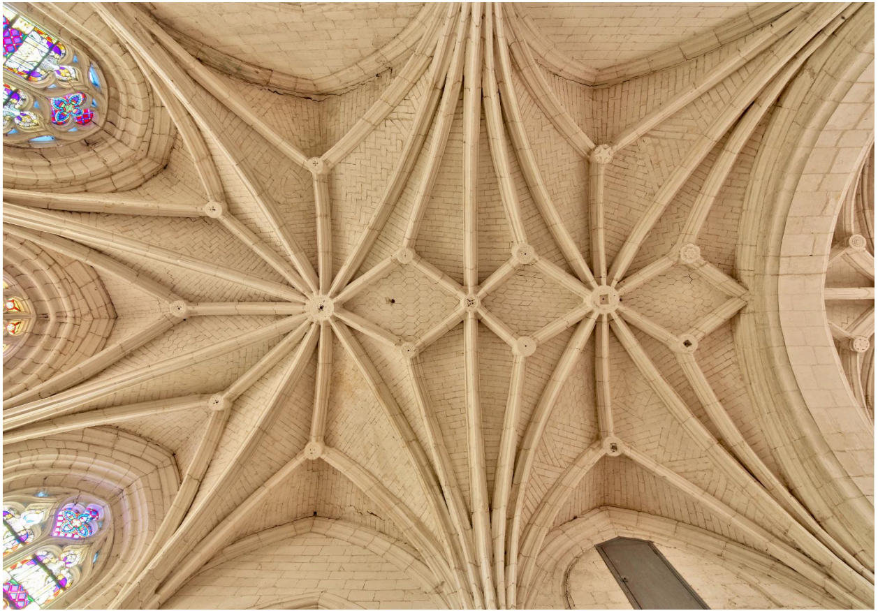
Vue de la voûte du chœur.
