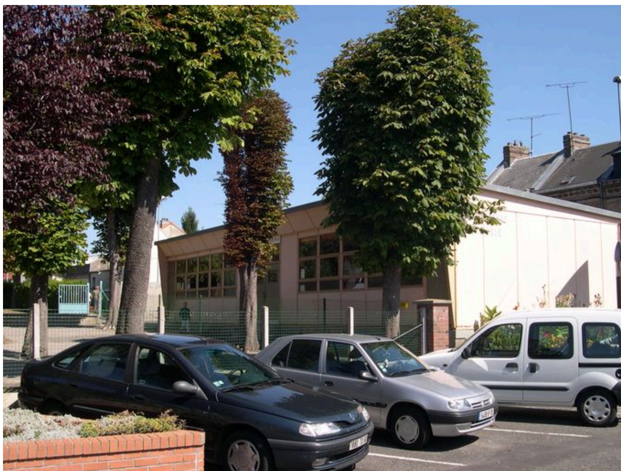
Baraquement à usage de bibliothèque, à l'est de la mairie école.
