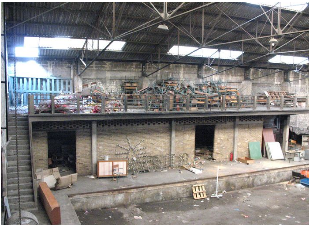
Quai de transbordement de la grande halle.
