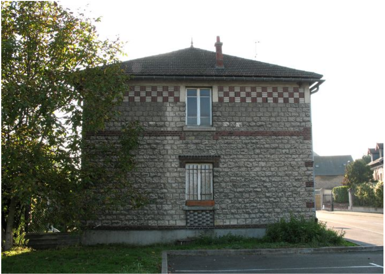
Mur pignon nord-est.
