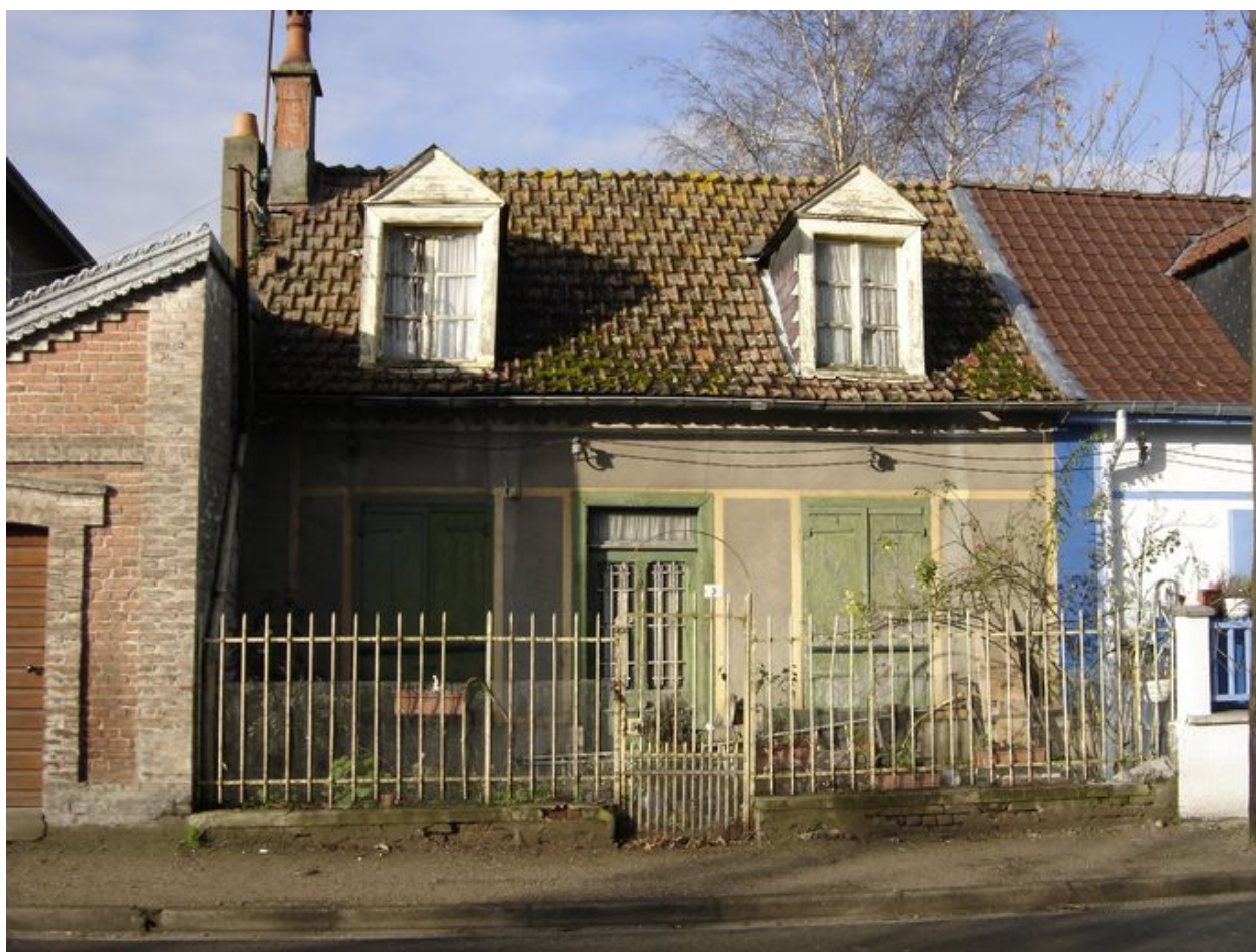
Vue du 3 rue du Général Leclerc.
