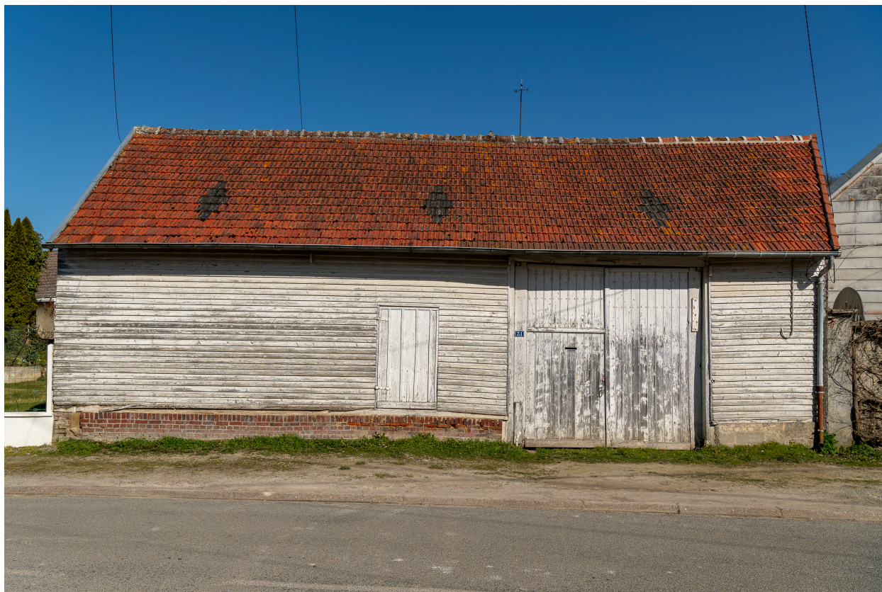
Grange sur rue, n°31 de la rue Yves-Maréchal, vue depuis l'ouest.
