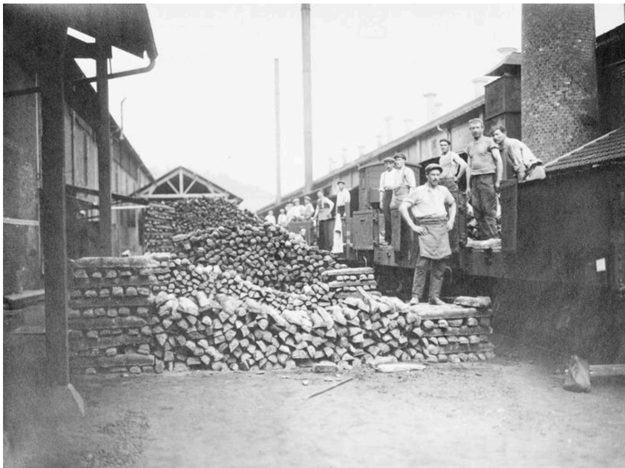
Vue de la chauffe (AP).
