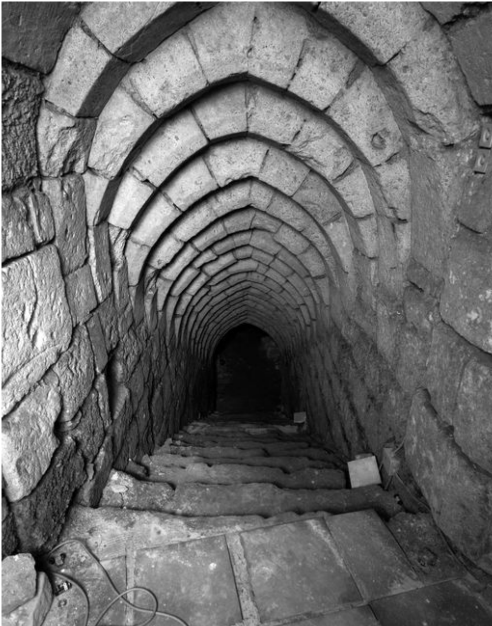
Escalier vers le 2e étage de sous-sol.
