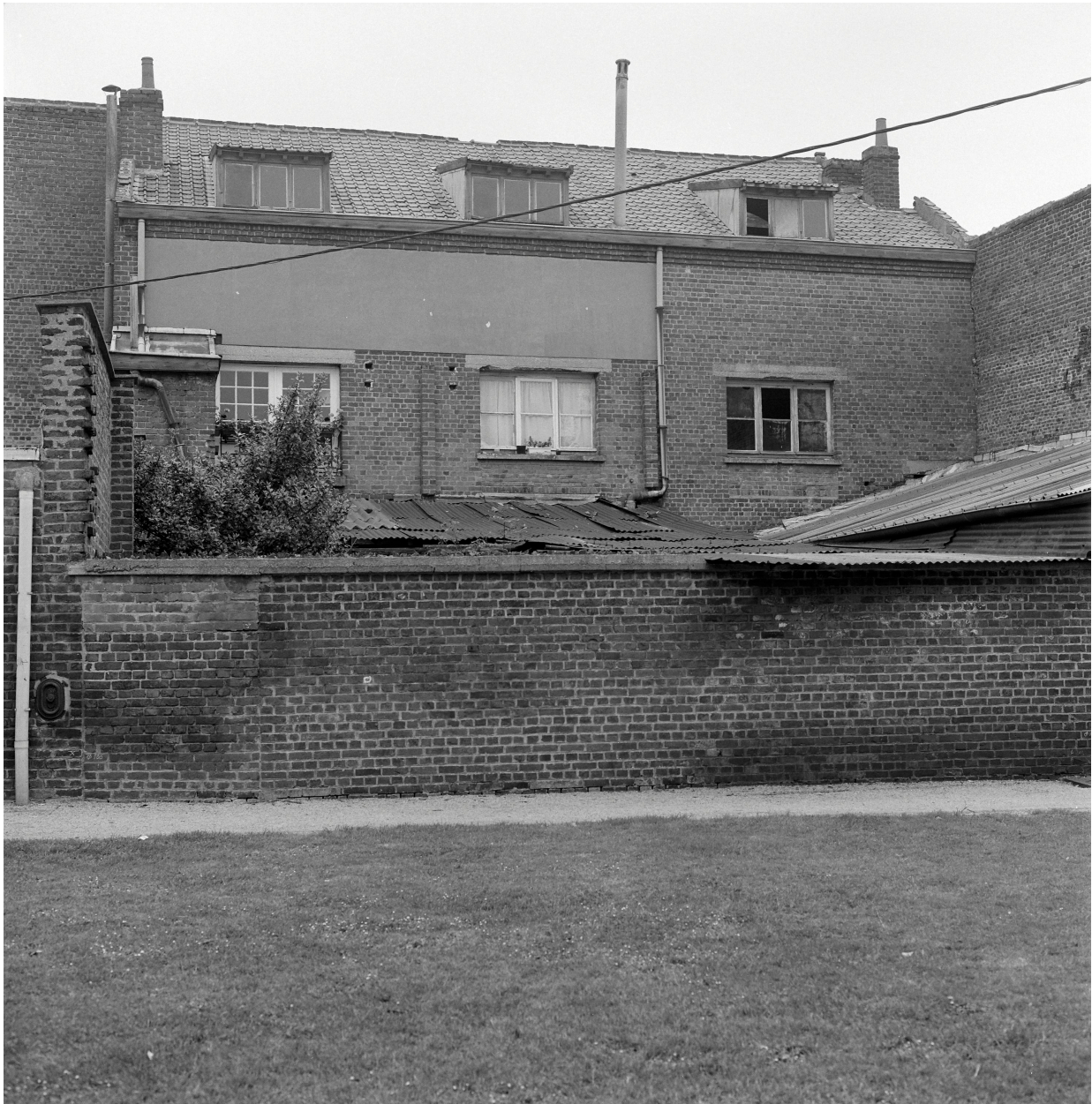
Élévation postérieure de la sacherie.
