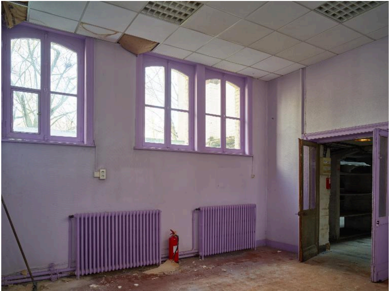
Bâtiment administratif, rez-de-chaussée : vue générale de la salle de triage. À droite, l'entrée du dépôt.
