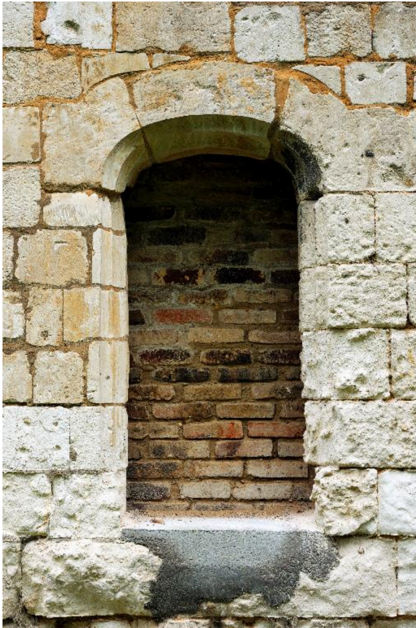
Baie murée d'un bâtiment prioral.
