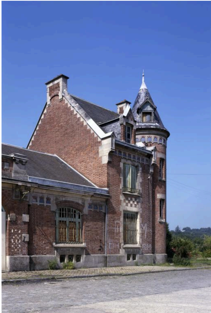
Détail du pavillon d'angle de la façade sur la place.
