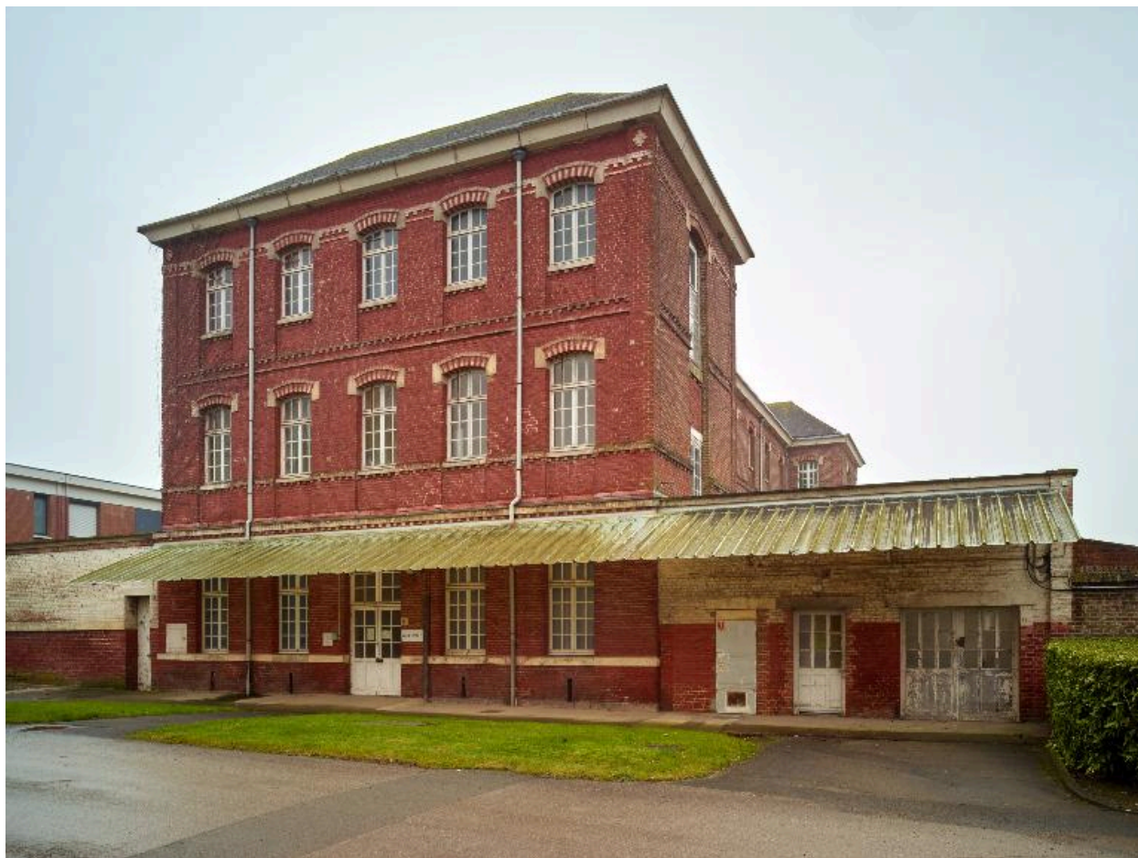
Bâtiment d'hospitalisation dit pavillon 6, élévation latérale donnant sur l'espace médian constituant l'axe de l'établissement, vue de trois quarts droit.
