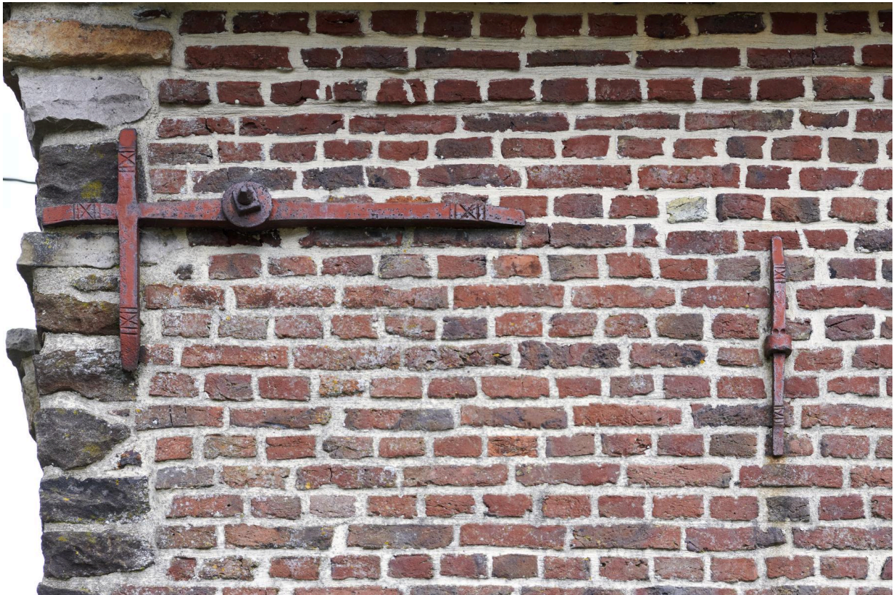
Détail des fers d'ancrage.
