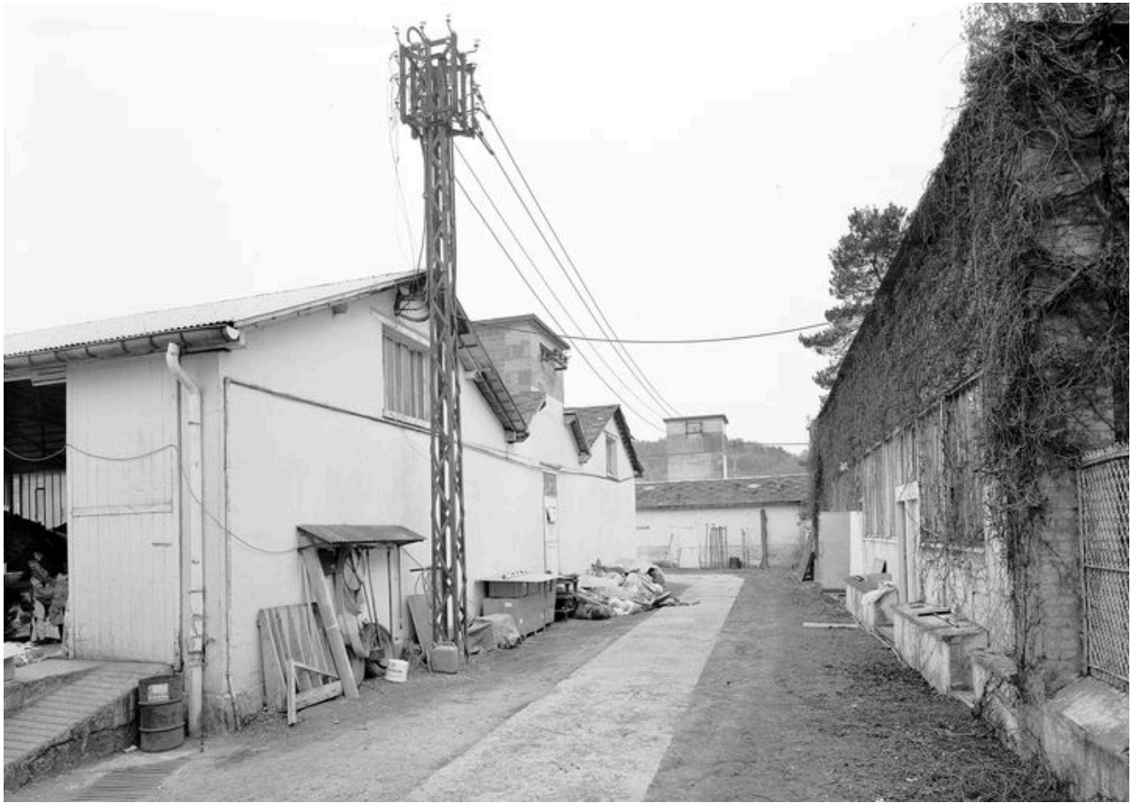
Atelier de fabrication de robinetterie : flanc ouest.
