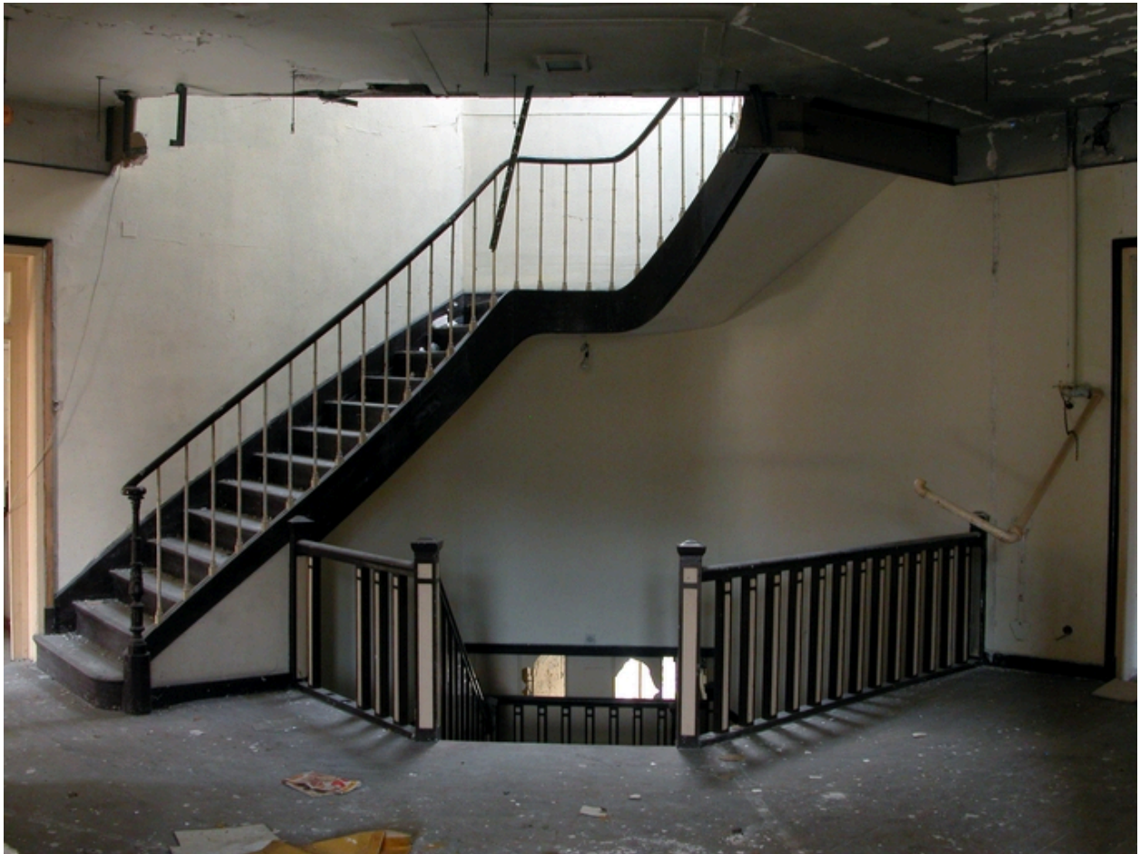
Escalier implanté à l'angle des rues de Mulhouse et Richard-Lenoir (premier étage).
