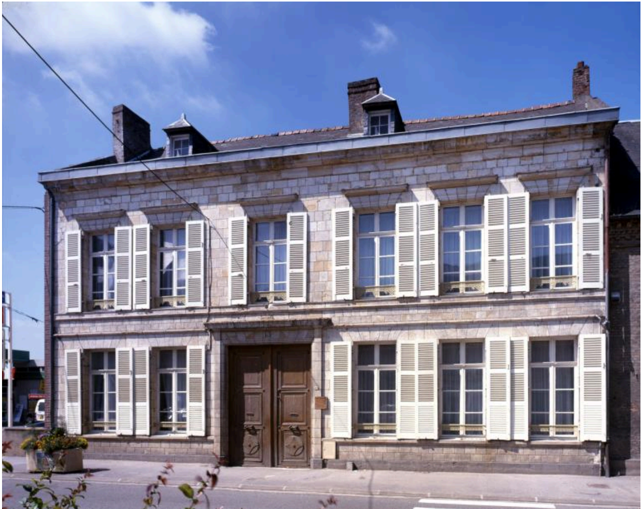
Vue de la façade en pierre sur rue de l'hôtel datant du milieu du 19e siècle, situé rue Sadi-Carnot (N°115).
