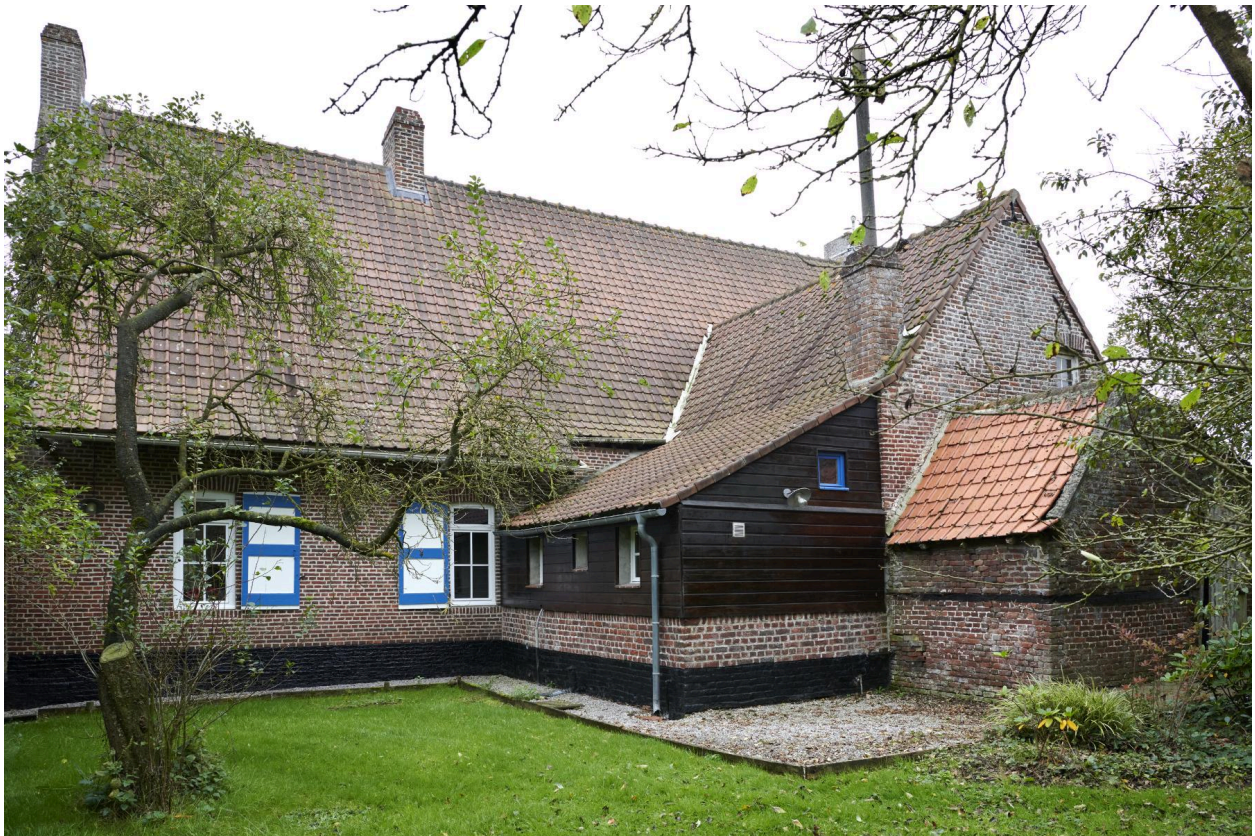
Extension XXe siècle qui accueille la cuisine.
