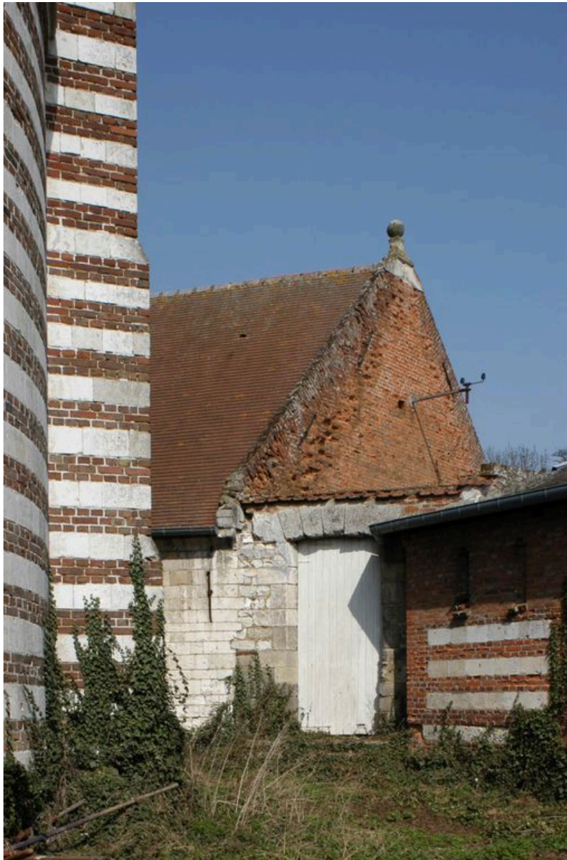
Vue de la porte donnant accès à la cour de la ferme.
