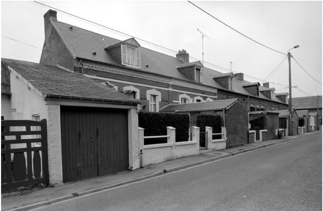
Logements d'ouvriers (rue Curie), vue générale, en 1991.
