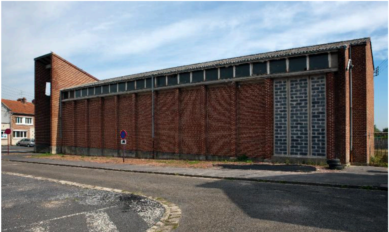
Élévation latérale (la verrière du chœur a été murée entre 2010 et 2014).
