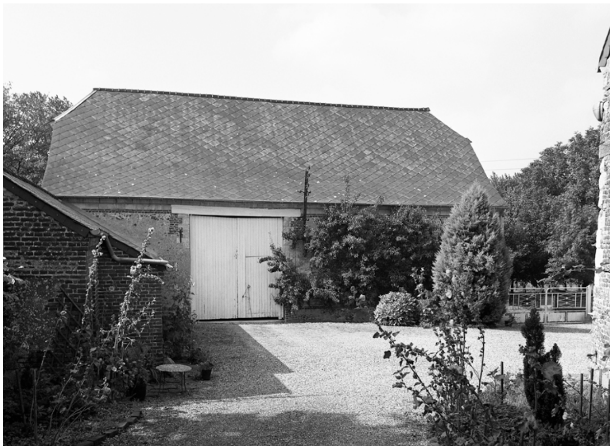
Grange : élévation sur cour.
