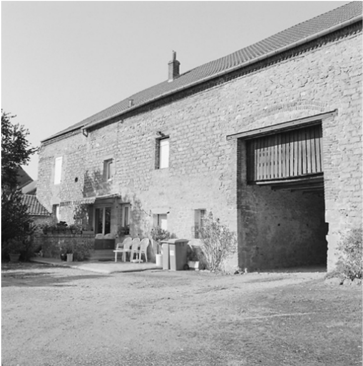
Vue de l'élévation postérieure du logis, d'une étable et du passage chartier.
