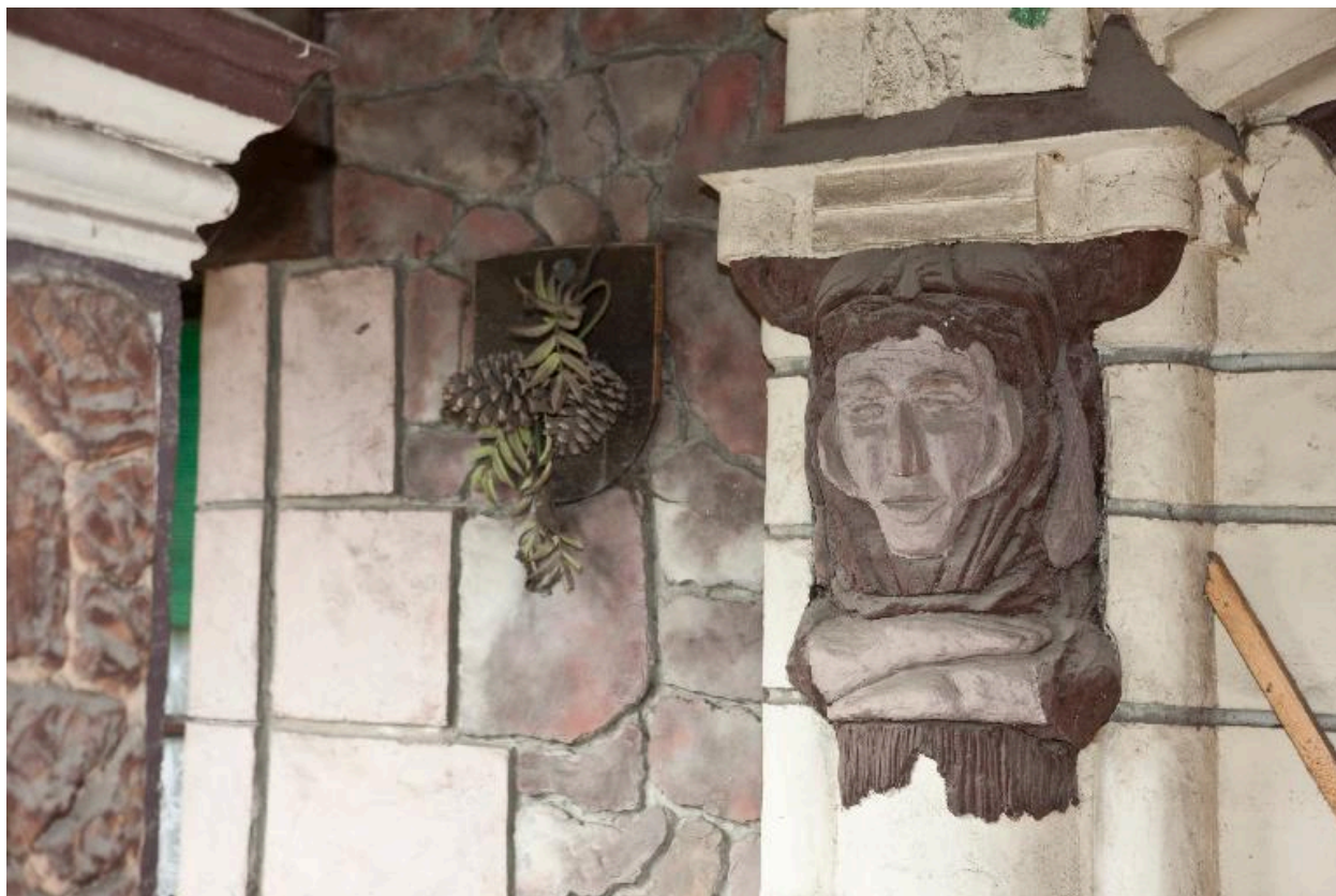
Détail de piliers d'arcade.
