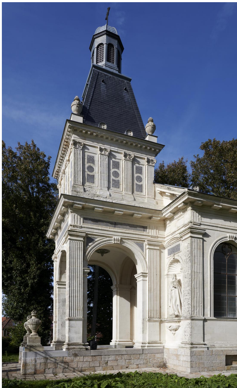
Vue latérale du clocher-porche.
