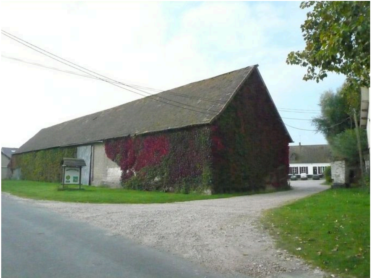
Vue générale sur le sud de l'ensemble.
