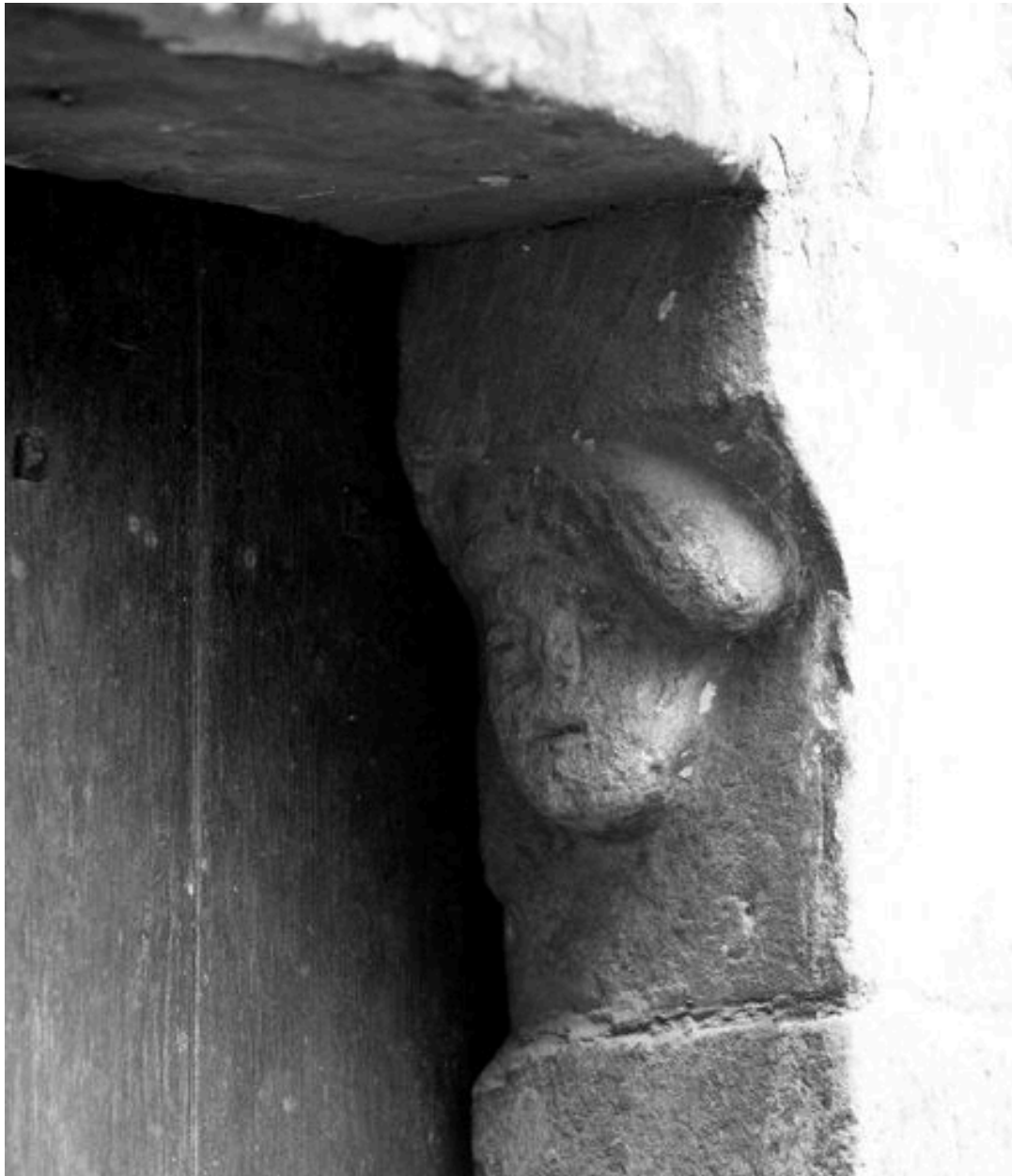
Corps de logis médiéval, façade arrière, tourelle d'escalier (ouest), rez-de-chaussée, porte d'accès, détail : tête masculine sculptée sur le coussinet portant le linteau.
