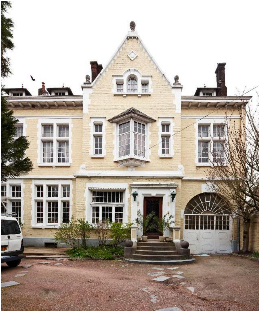
Maison bourgeoise datant du début du XXe siècle (?), 28, rue du Fort.
