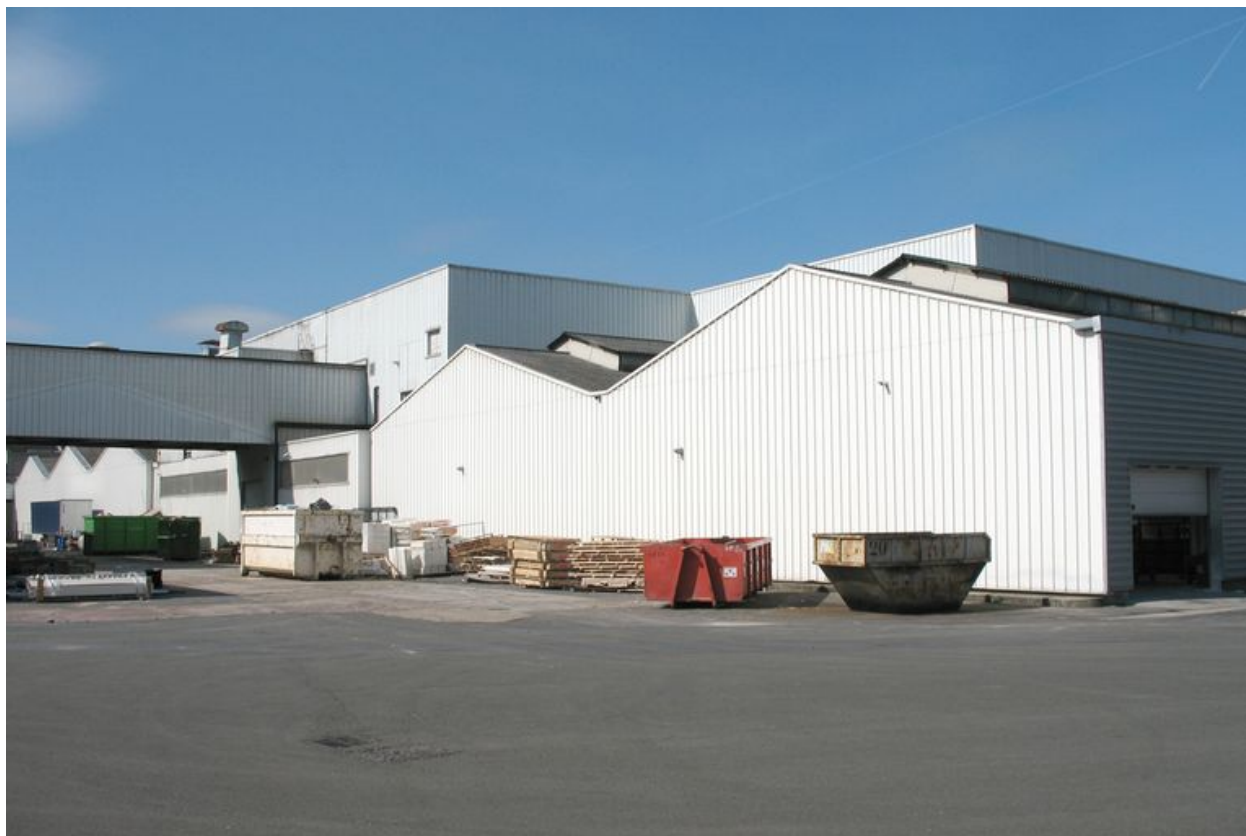
Anciens magasins de stockage des pièces.
