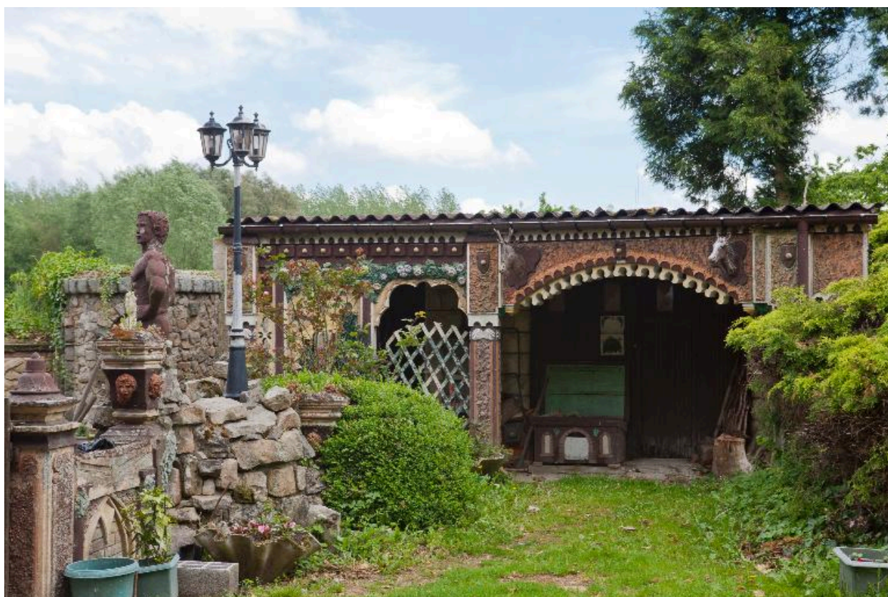
Vue générale depuis l'entrée.
