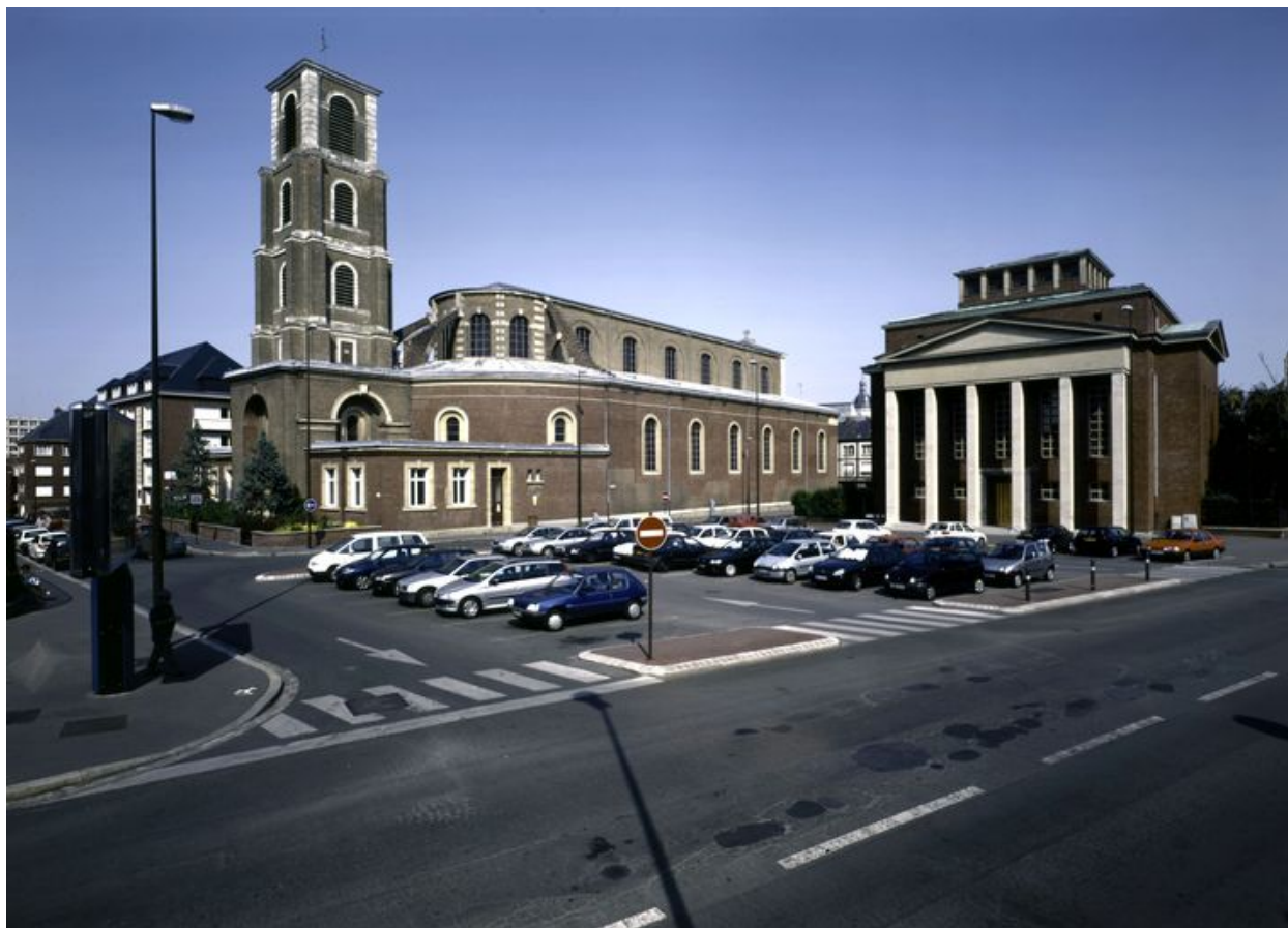
Vue de situation, depuis le sud-ouest.
