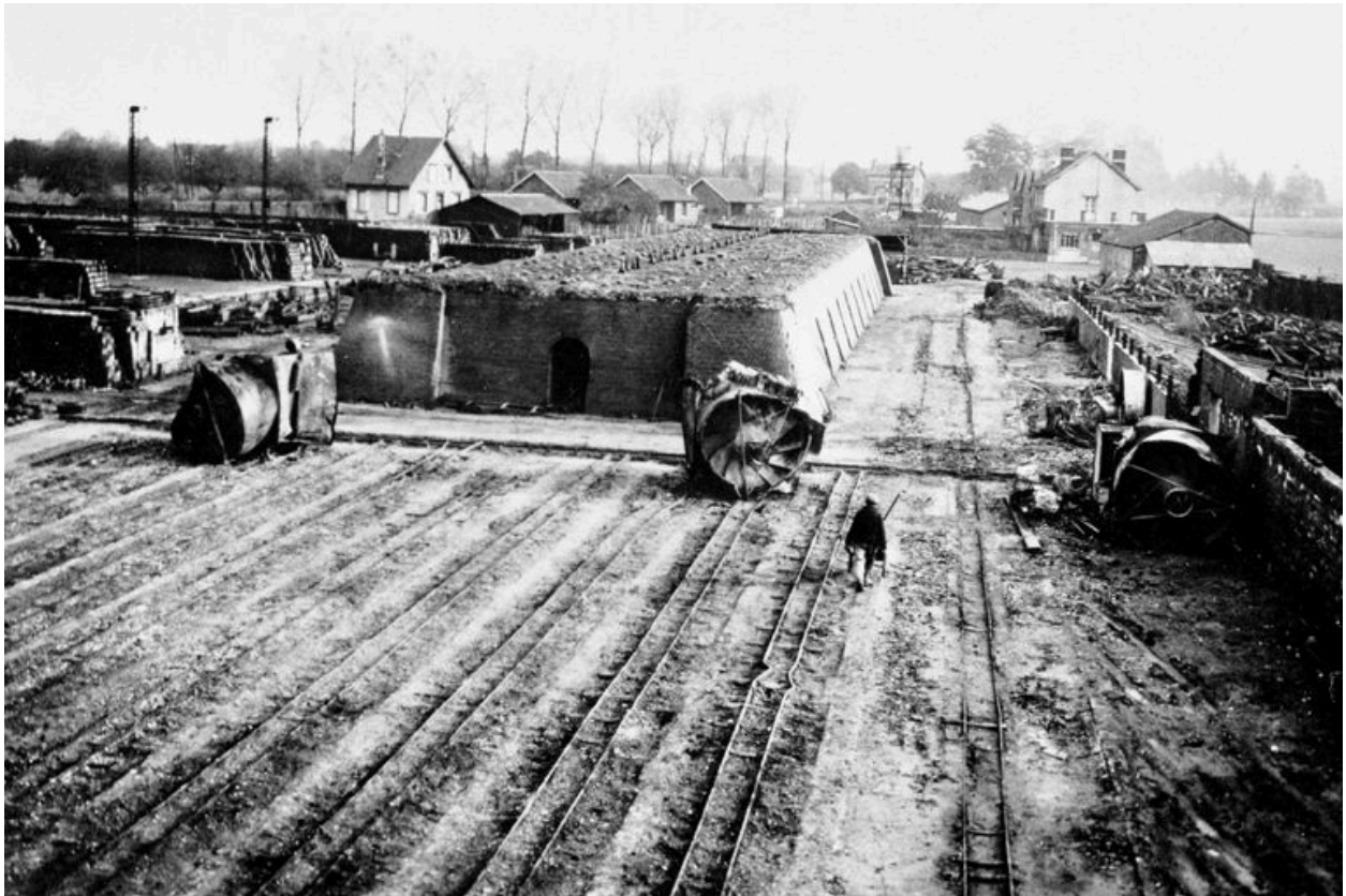
REMY. Briqueterie Bohy. Vestiges des rails de séchage des briques et du four, après l'incendie du 19 septembre 1934 (AP).
