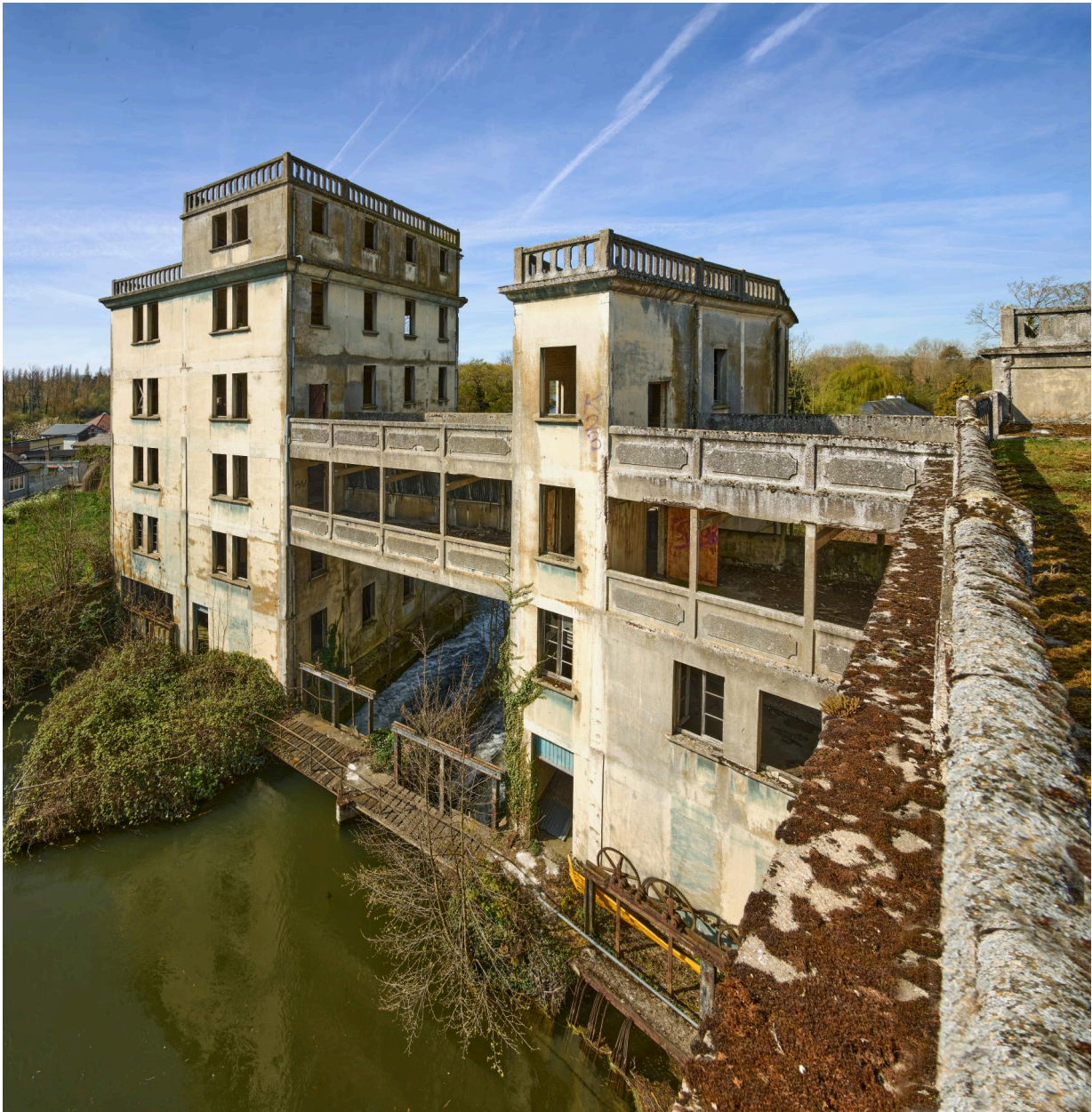
Vue d'ensemble de la minoterie depuis la terrasse des magasins.
