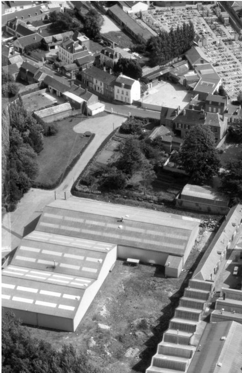
Vue aérienne, flanc nord-est, en 1988.
