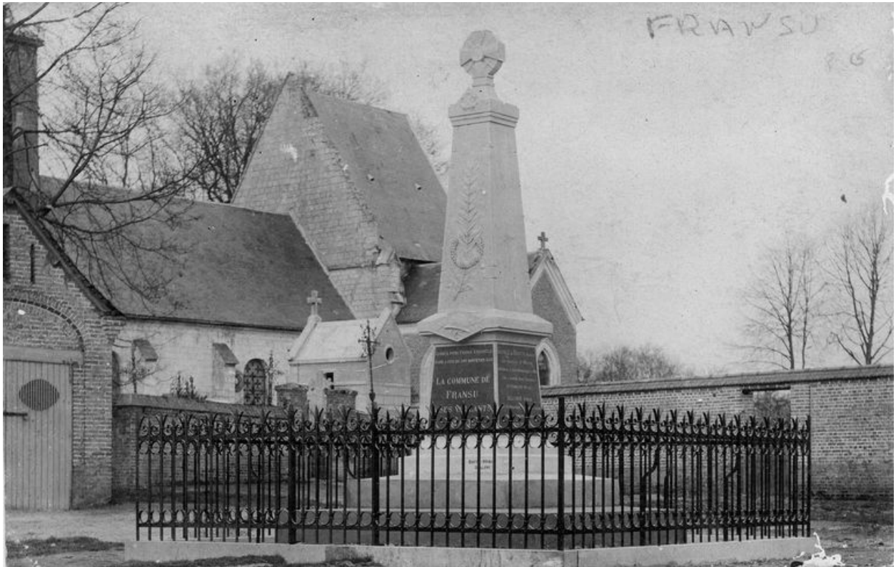
Vue générale, après 1922 (coll. part.).
