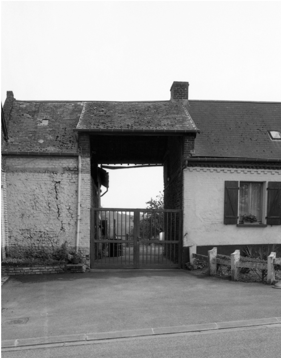
Vue de détail de la grange et de sa porte charretière.
