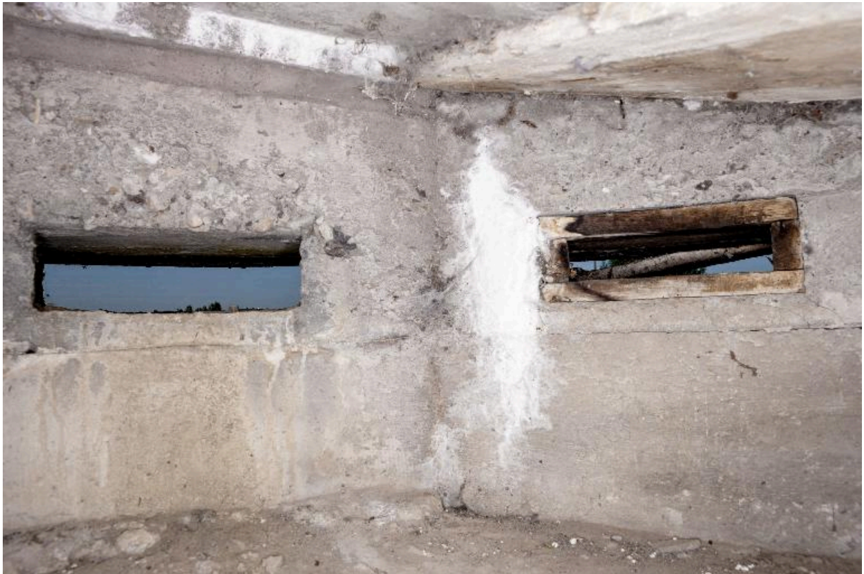
Observatoire bétonné, détail des embrasures de surveillance
