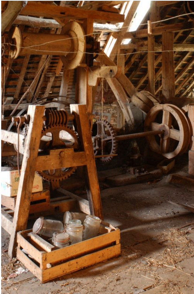
Intérieur du comble, détail du treuil et les mécanismes de transmission supérieurs.
