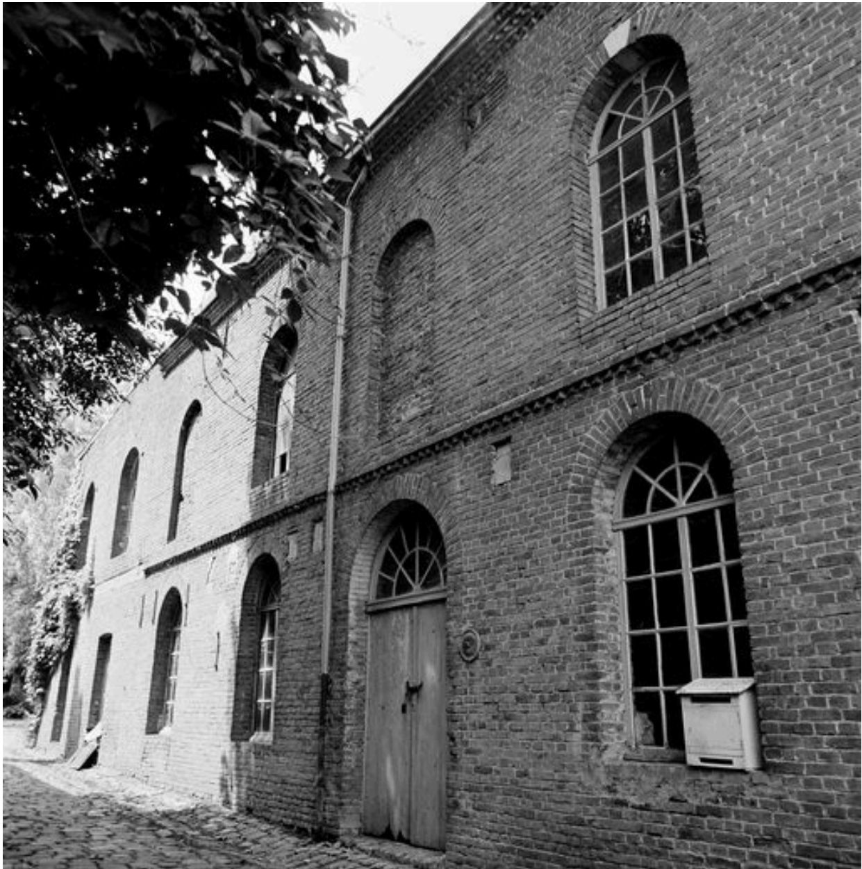
Atelier de fabrication : façade longitudinale.
