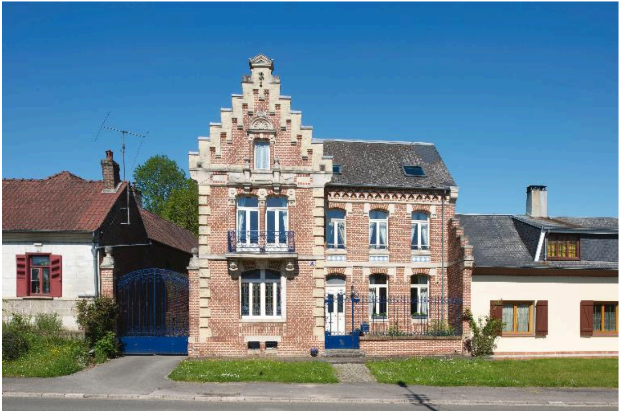
Façade sur rue, vue de face.
