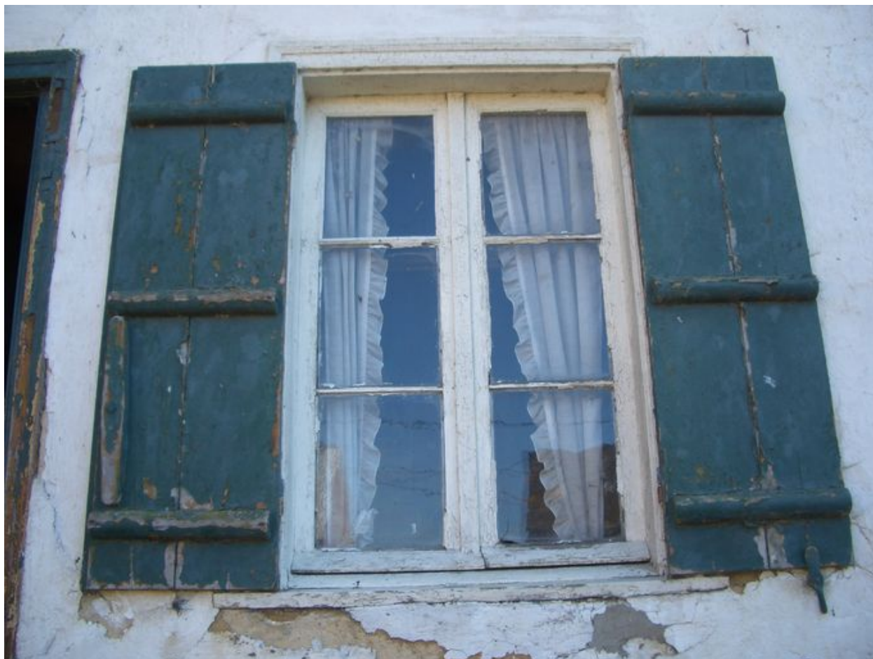
Vue d'une fenêtre avec contrevent et système de fermeture, fixé par un tourniquet en fonte.
